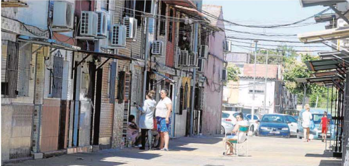
Una de las calles del barrio de Torreblanca, donde se observa una maraña de cables eléctricos y diversos aparatos de aire acondicionado // MANUEL GÓMEZ
