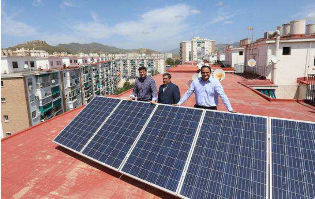
Instalación fotovoltaica en la cubierta de un edificio de la capital. / FERNANDO GONZÁLEZ
