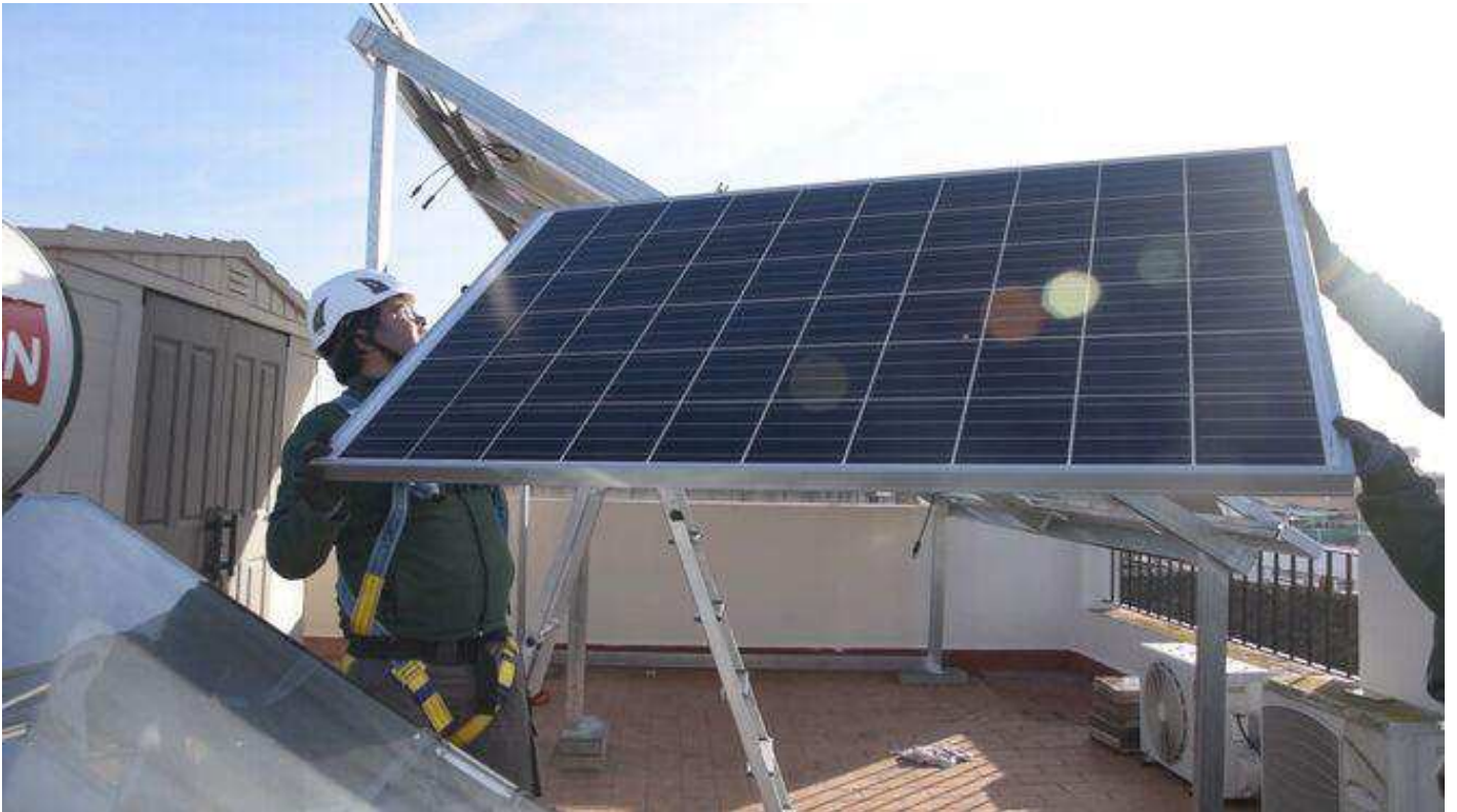
Instalación de paneles fotovoltaicos en la azotea de un edificio. / AGENCIA ANDALUZA DE LA ENERGÍA
