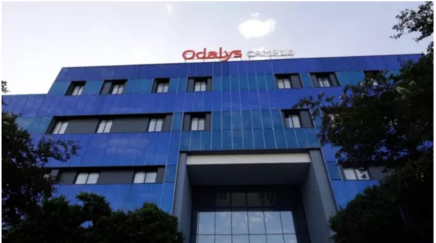
Fachada ventilada fotovoltaica de la residencia de estudiantes. - JUNTA DE ANDALUCÍA
