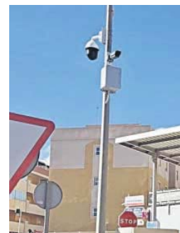
Una de las cámaras instaladas.
