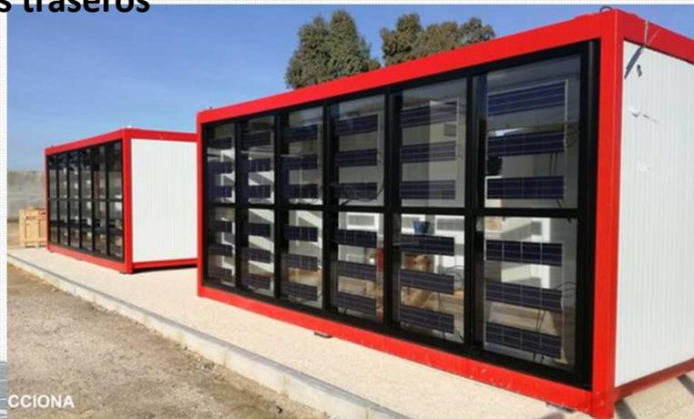
Instalación en Sevilla (Acciona) de módulos de baja concentración y control solar (Tecnalia), con tecnología de lentes de Fresnel que desvían la radiación hacia las células en verano.
