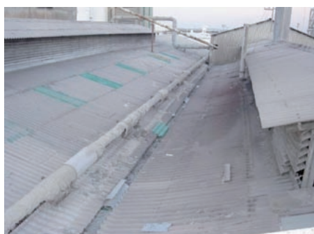
Fig. 26: Fotografía y termografía de la red de distribución de vapor.
