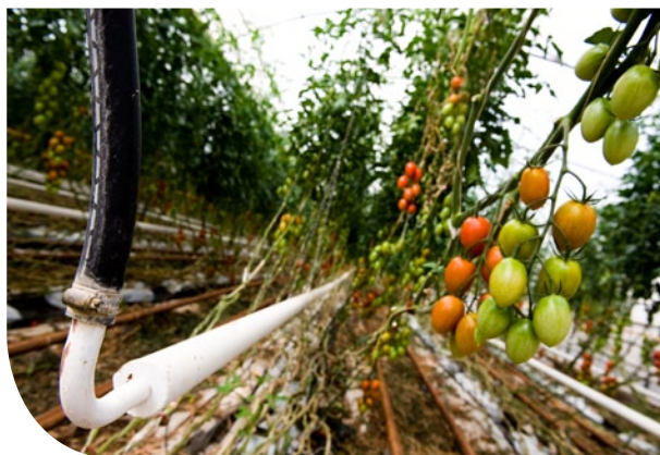
Distribución de calor y CO 2 obtenido por cogeneración en invernadero (Almería)
