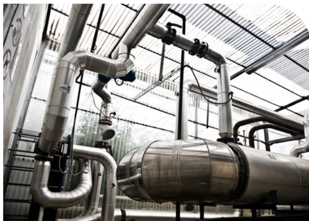
Distribución de calor y CO 2 obtenido por cogeneración en invernadero (Almería)
