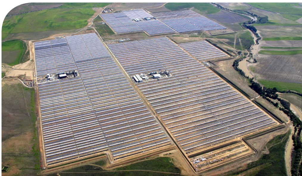
Planta termosolar Andasol (Granada)
