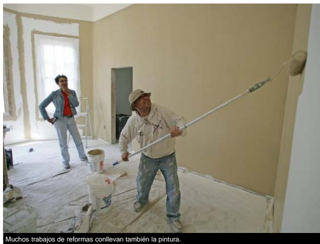
Muchos trabajos de reformas conllevan también la pintura.
