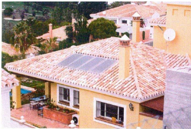
Figura 4.3: Instalación integrada de circulación forzada
