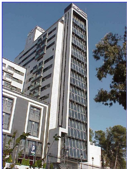
Figura 4.1 Hotel con campo de captadores situado en escalera de incendios
