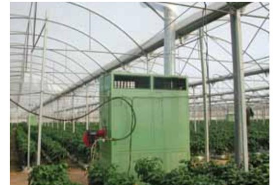
Vista de un generador de aire caliente para calefacción de un invernadero.
