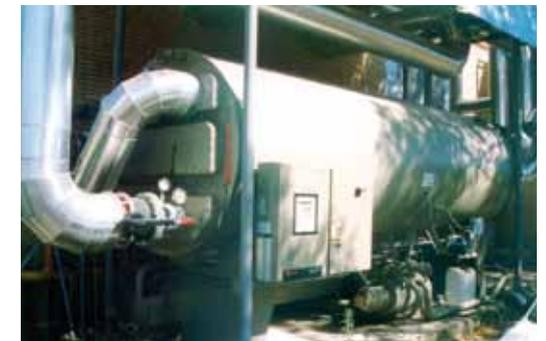
Equipo de absorción de una planta de cogeneración en un centro hospitalario.
