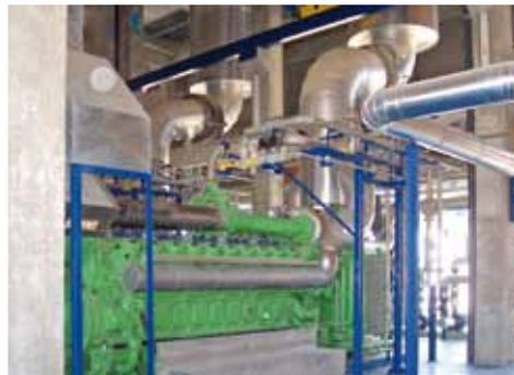
Motor de cogeneración de depuradora municipal para secado de lodos. Combustible: biogás.
