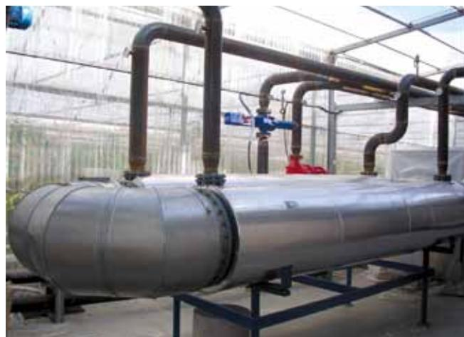
Conductos de escape de motor de cogeneración.
