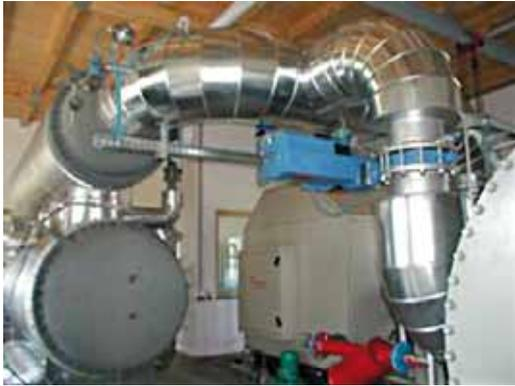
Recuperador de calor de planta de producción de electricidad de una cementera mediante ciclo orgánico de Rankine.
