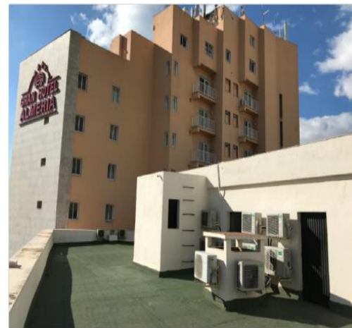
Detalle de la cubierta del edificio de Almería donde se aprecia al fondo el edificio anexo que la sombrea
