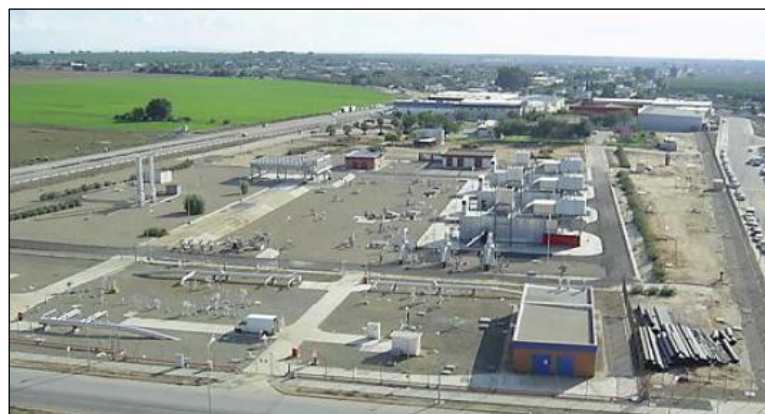
Fuente: ENAGAS. Estación de compresión de Dos Hermanas
