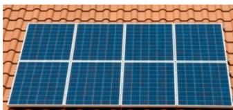
compuestos por células fotovoltaicas, responsables de transformar la luz del sol en energía eléctrica útil para nosotros. Esta electricidad se puede utilizar directamente o almacenarla en baterías para cuando sea necesaria y así poder hacer uso de ella, tanto de día como de noche.
