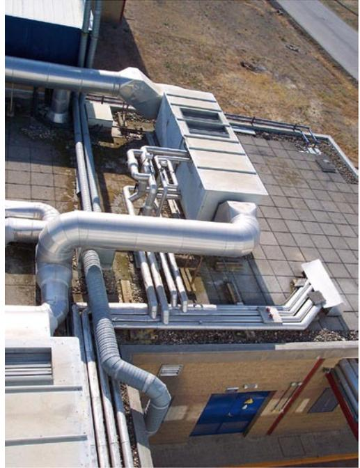
Figura 59. Climatizador con configuración a cuatro tubos.
