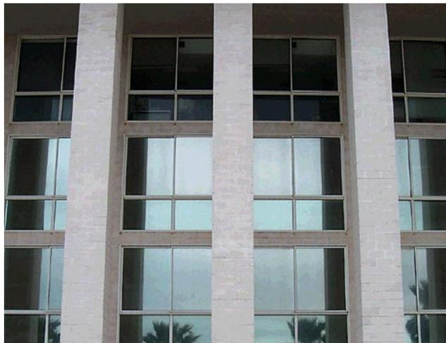
Figura 36. Ventanales con láminas solares.
