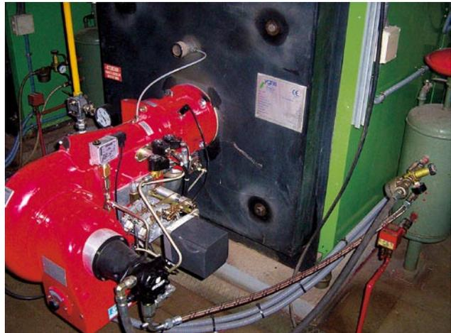
Figura 46. Quemador de gasóleo.
