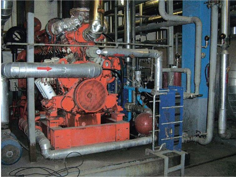
Figura 96. Motor alternativo de gas natural de una instalación de cogeneración.
