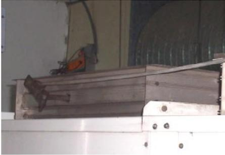
Figura 49. Detalle de las compuertas de aire exterior y expulsión en un climatizador con enfriamiento gratuito.
