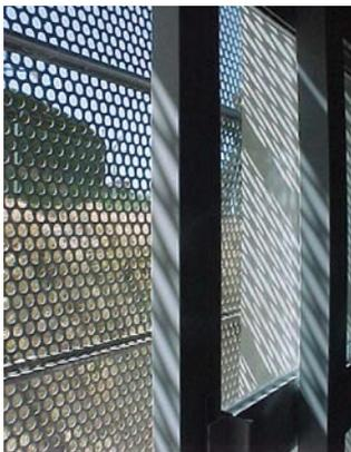
Figura 82. Ventana con protecciones solares exteriores.
