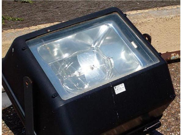
Figura 69. Foco exterior con control horario.
